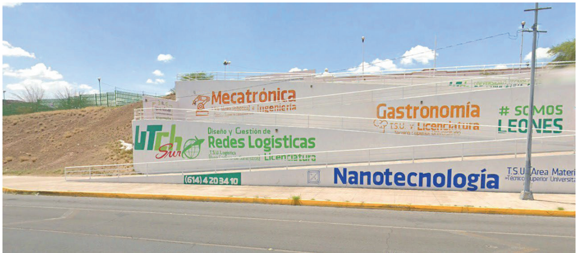
IMAGEN 45.- Instalaciones UTCH Sur. Fuente. Elaboración propia.
