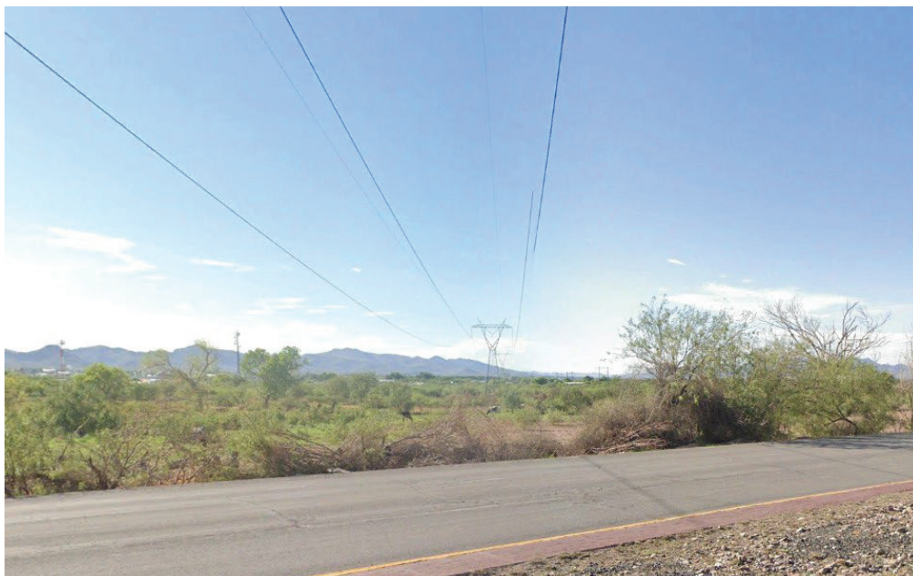
IMAGEN 63.- Líneas de alta tensión en la zona. Fuente: Elaboración propia.
