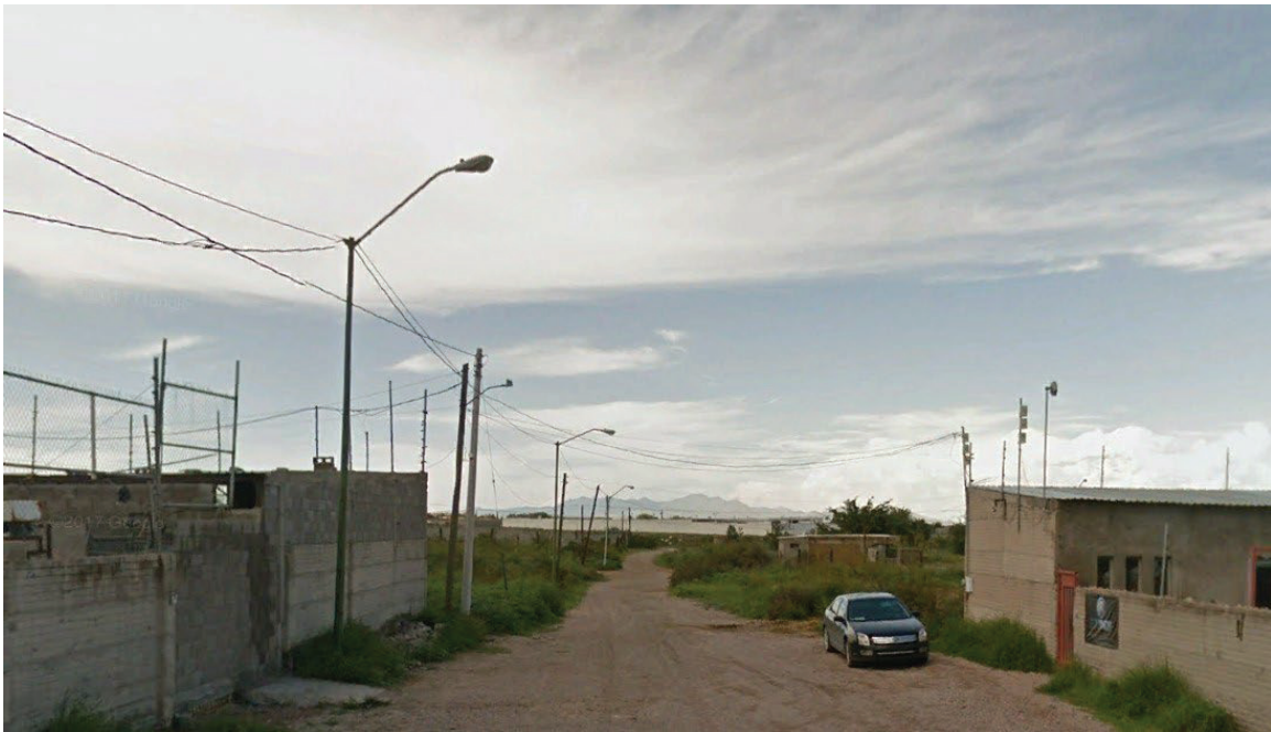
IMAGEN 66.- Luminarias en la colonia Valle de Chihuahua. Fuente: Elaboración propia.
