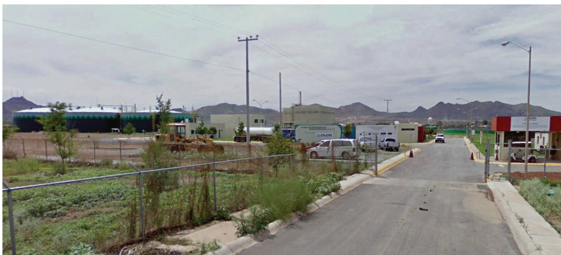
IMAGEN 77.- Planta de Tratamiento de Aguas Residuales Sur. Fuente: Elaboración propia.
